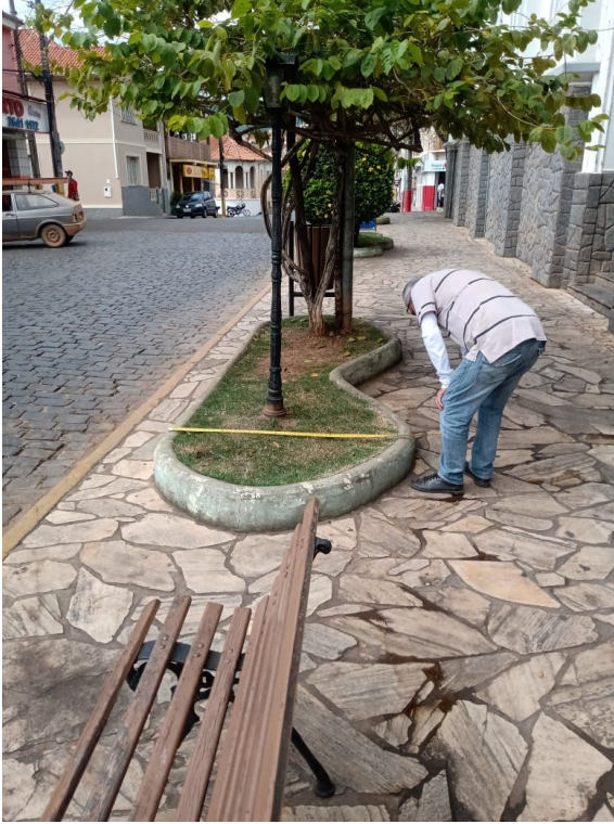
Figura 10- canteiro existente a demolir
