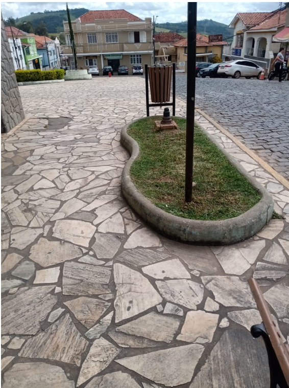
Figura 9 - canteiro existente a demolir
