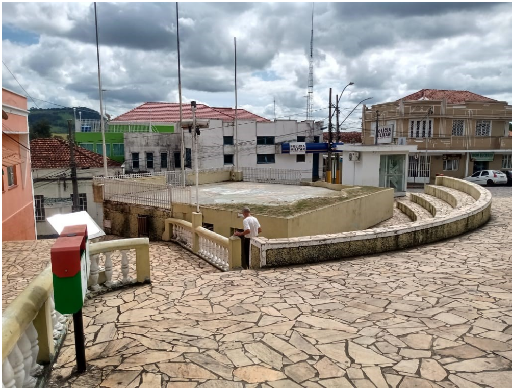
Figura 4 - área de elementos a manter e pintar (palco, muretas, arquibancada)
